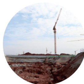
边坡治理 (锚索、锚杆、格构、网喷)
